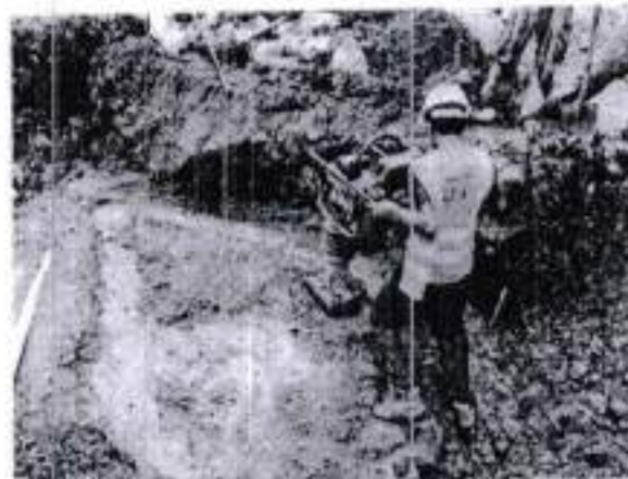
Relleno y compactado con material del sitio sobre tubería de desagüe
