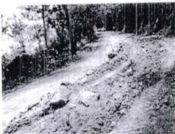
Proceso de estabilización con cemento
